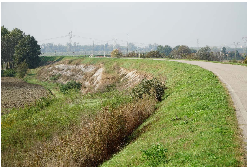
Figura 4-12: esempio di rivestimento in lastre in cls sul paramento lato fiume lungo il tratto oggetto di intervento
